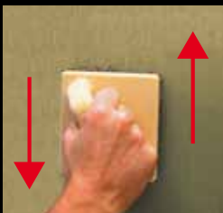
creare delle striature verso una direzione con l'apposita spazzola create some brush marks in one direction with the specific brush
