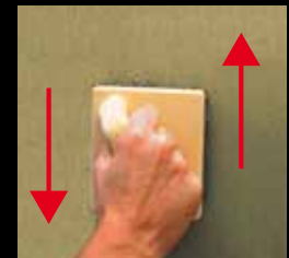
ricreare delle striature con l'apposita spazzola recreate some brush marks with the specific brush
