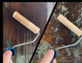
applicare una mano di isolex W apply a layer of isolex W
