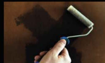
applicare isolex W con rullo a pelo corto apply isolex W by short pile roller
