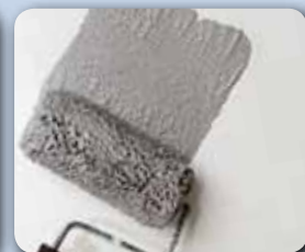
4. A seconda del ciclo d'intervento più idoneo finitura a rullo o pennello con: - beton decor coprente - PG7 fondo coprente 0.584 + beton decor elastomerico
