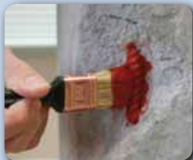
1. Applicazione boiaccia passivante su ferro d'armatura
