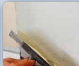
3. Rasatura con beton decor rasante su superficie ripristinata.
