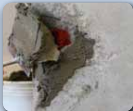
2. Ripristino con ard malta rapida
