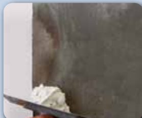
3. Rasatura con beton decor rasante su superficie ripristinata.
